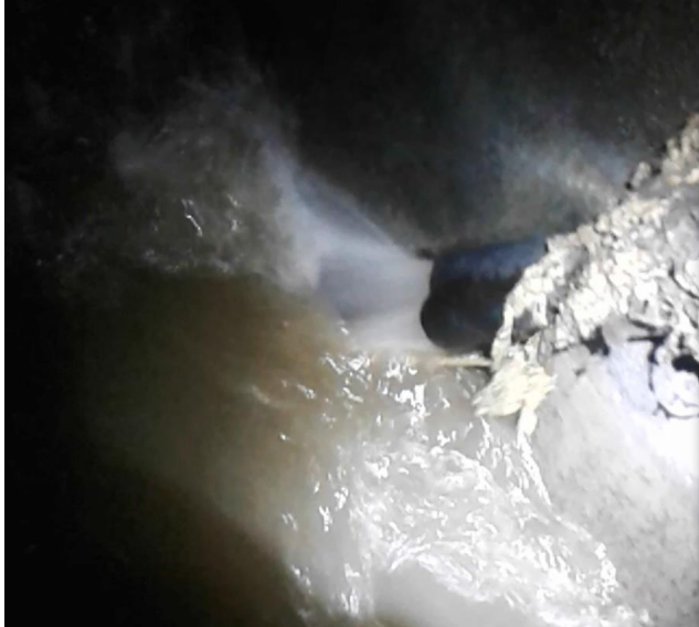
Vanne de vidange défectueuse déversant de l'eau potable dans le réseau d'assainissement
