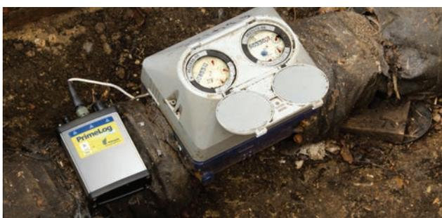
**Compteur domestique et abonné** L'index compteur est paramétrable dans l'enregistreur. Combiné à une dimension réduite de l'appareil, il devient l'outil idéal pour le dimensionnement d'installation.
