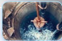
Des impulsions ultrasonores sont réfléchies à la surface et réceptionnées au niveau du capteur. Ce capteur est particulièrement dédié pour des applications de conversion hauteur/débit sur seuil ou déversoir et pour la surveillance des déversoirs d'orages.
