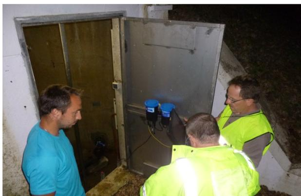
Alors que la couverture GSM ne permet pas de téléphoner, 100% des données sont transmises en temps réel en GPRS par l'XStream
